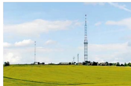
■ Pohled na kopec Předina s vysílačem vysokým 156 metrů
