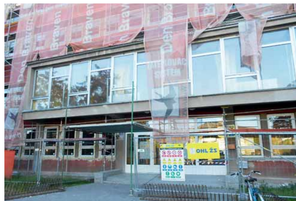
■ SOŠ a SOU v Šumperku se dočká zateplení fasády. | Foto: IJ
