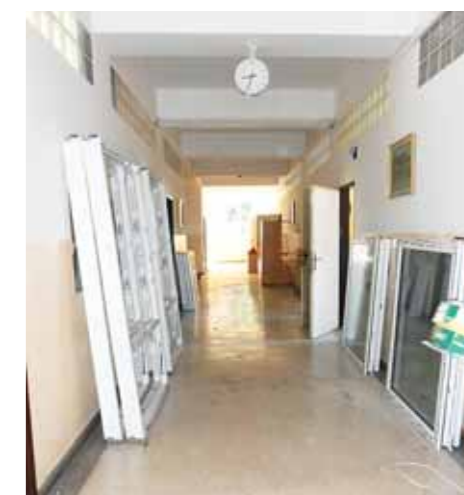
■ Nová okna, dveře a zateplení střech a fasád – nejčastější stavební úpravy. | Foto: IJ
