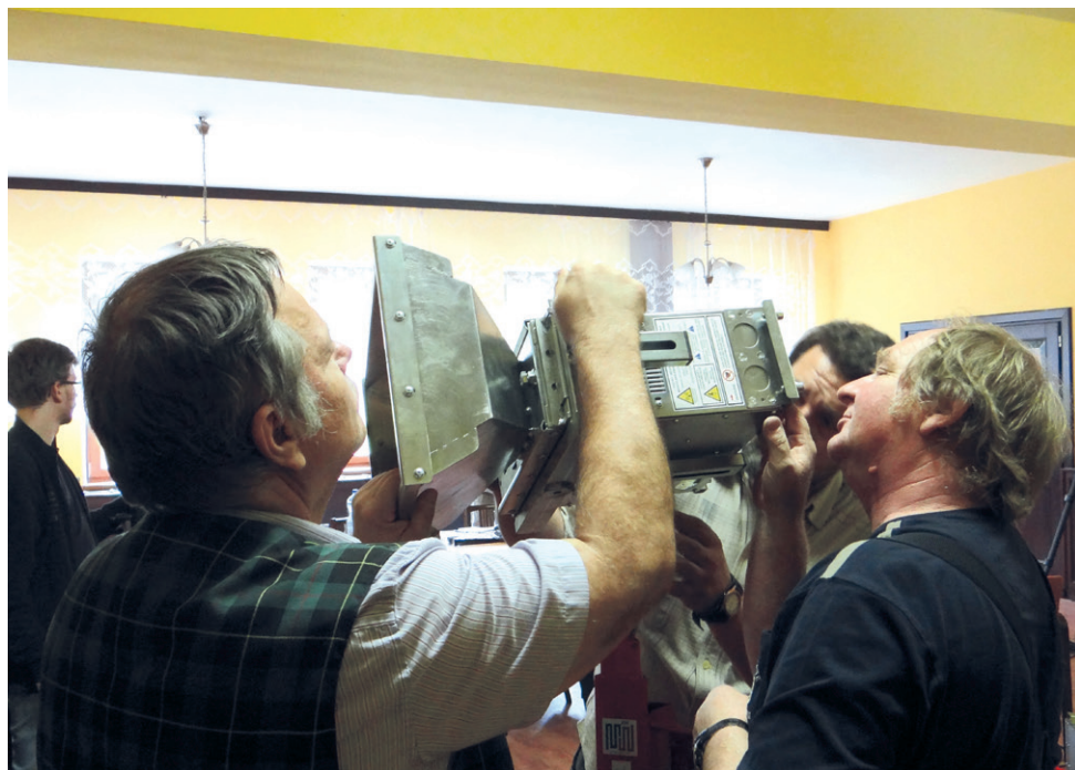
Nácvik instalace generátoru na krovový adapter - umožňuje práci generátoru pod libovolným úhlem. Využití u šikmého podbití, krovů, schodnic apod.
