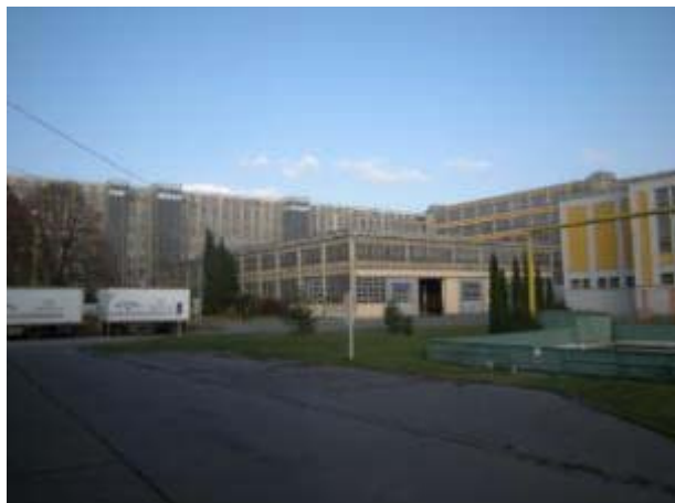
Ústřední budova skladů
