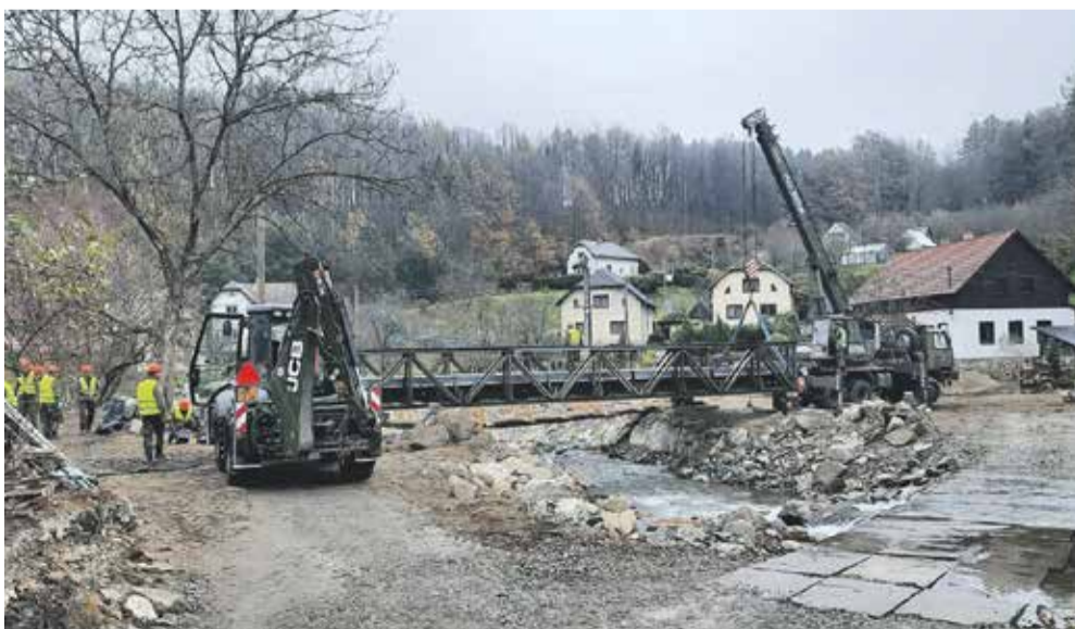
Vojáci v Olomouckém kraji postavili celkem 13 provizorních mostních konstrukcí.
