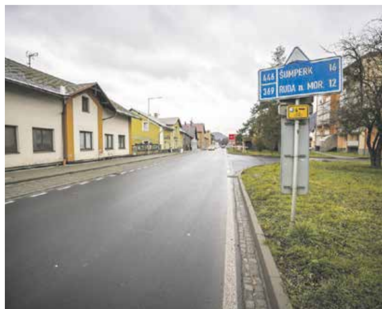
Opravu posledního úseku silnice přes centrum Hanušovic zkomplikovala velká voda.
