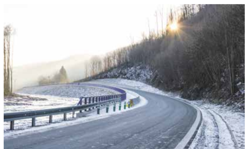
Na komplikovanou opravu silnice u Hanušovic dohlíželi i biologové, řidičům začala sloužit v polovině ledna. FOTO | OLMOUCKÝ KRAJ
