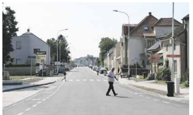
Řada silnic v kraji během prázdnin prošla rekonstrukcí, kraj se při rekonstrukcích zaměřuje na bezpečnost nejen řidičů, ale i cyklistů a chodců. Foto | Olomoucký kraj
