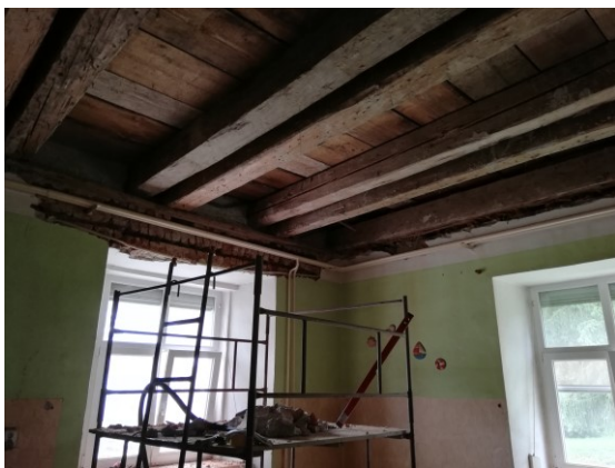
zajištění statiky a oprava stropů zámečku
