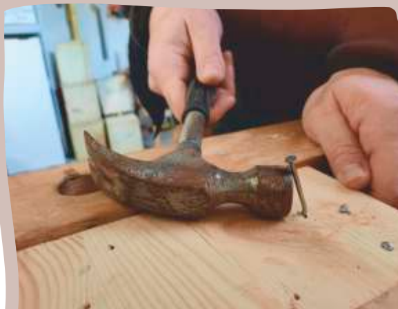
Narovnání křivě zatlučeného hřebíku úderem kladiva z boku.
