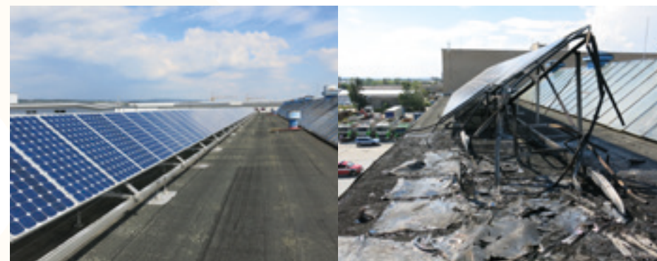
Požár fotovoltaické elektrárny
