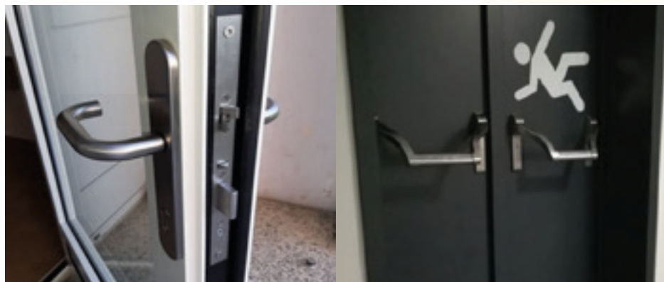
Zámky s panikovou funkcí, které se stisknutím kliky či madla při odchodu odemknou bez použití klíče
