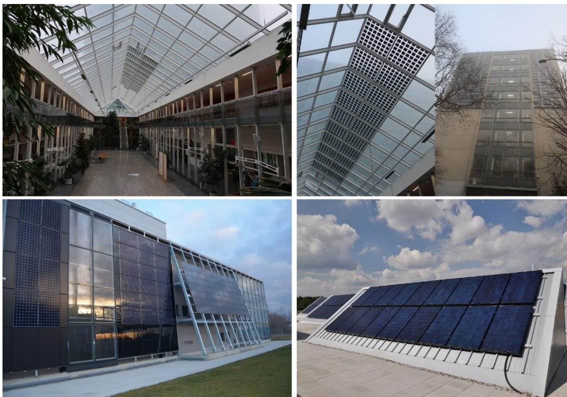
Obr. 78 Využití BIPV v praxi (ČVUT - nahoře Fakulta stavební - prosklené atrium s FV moduly sklo-sklo, fasáda se vzduchovou mezerou, dole UCEEB - fasádní bezrámové systémy a střešní systém na světlicích)
