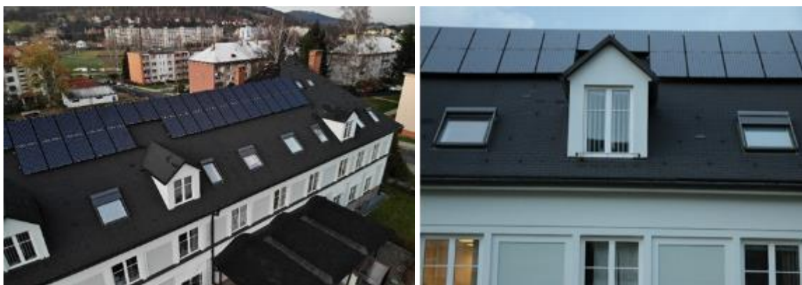
Obr. 40 Umístění FVE panelů u hřebene střechy
