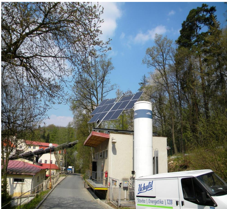
Obr. 85 Natáčecí FVE systém na střeše kyslíkové stanice
