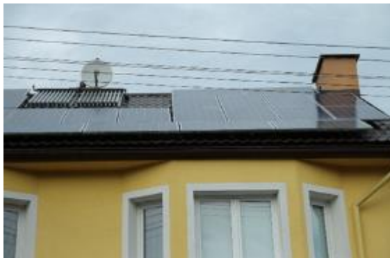
Obr. 32 FVE v kombinaci se solárním kolektorem
