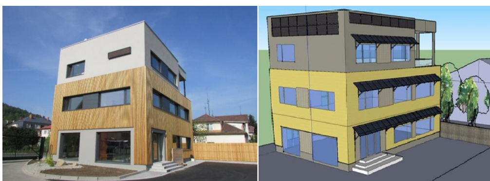
Obr. 77 Příklad návrhu rozšíření FV systému na administrativní budově o výkonu 8,4 kWp pomocí fasádního systému a stínících prvků nad okny
