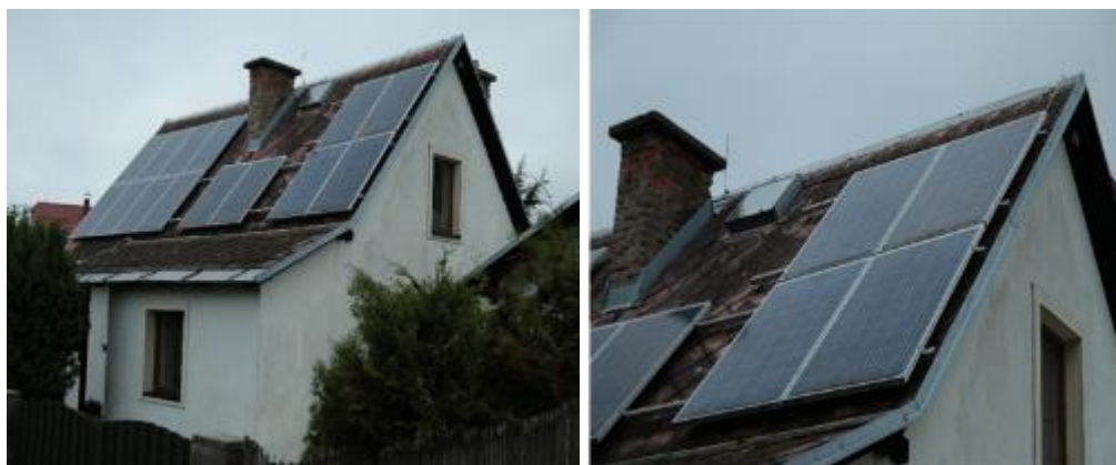
Obr. 38 FVE na střeše s eternitovou krytinou a připojením na hromosvod
