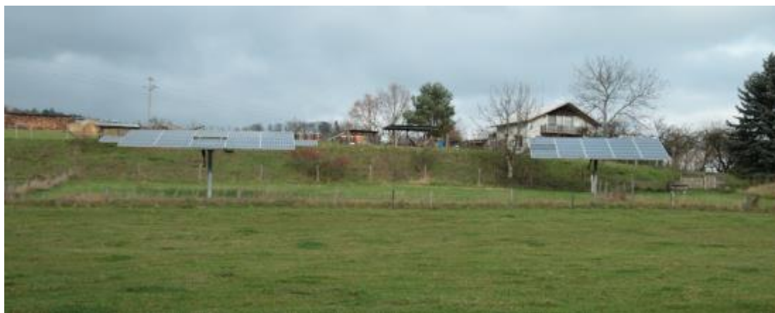
Obr. 36 FVE s polohovacím systémem
