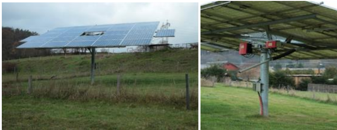
Obr. 37 Technická zařízení pro FVE s polohovacími systémy
