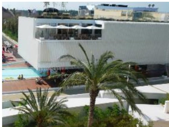
Obrázek 21 Pohled na vertikální zastínění
