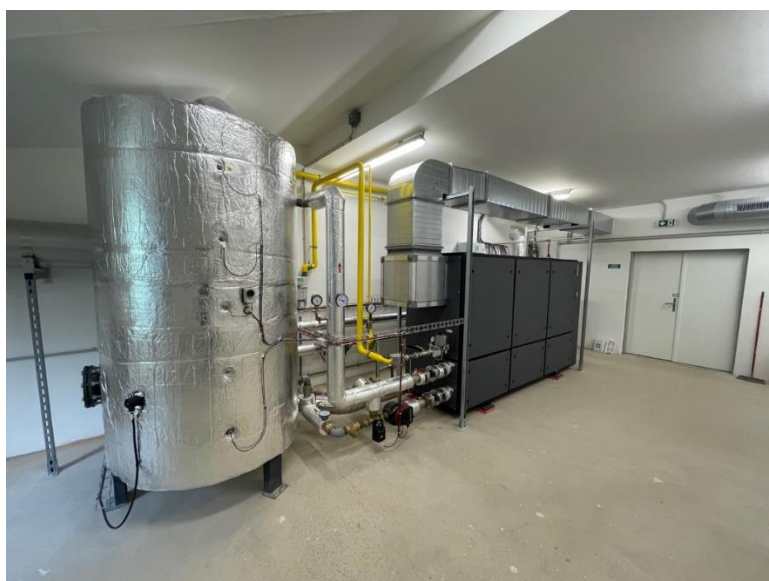
Obr. Kogenerační jednotka v objektu zimního stadionu města Břeclav
