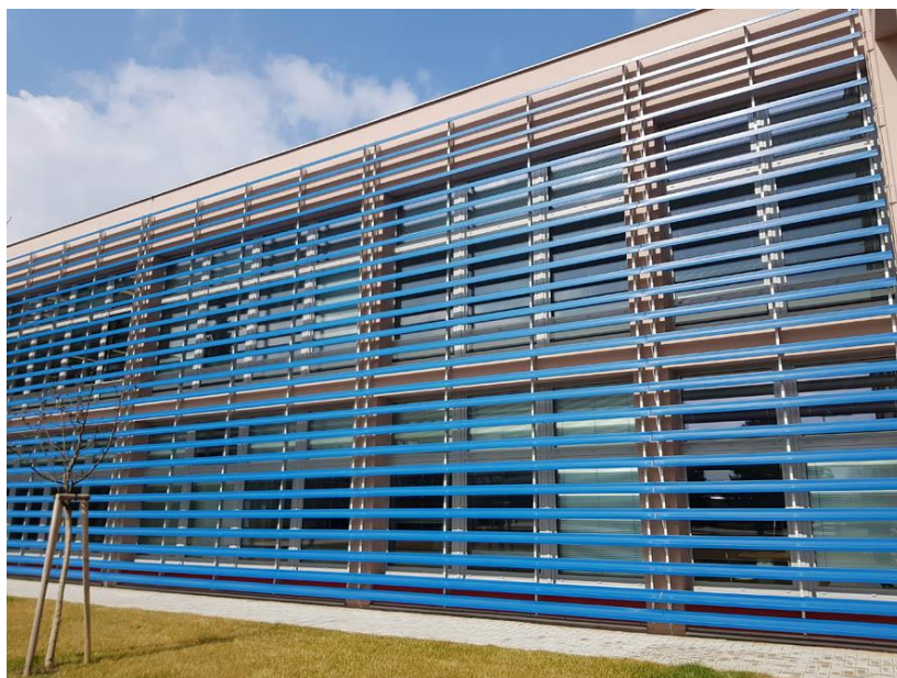
Příklad dodatečné instalace slunolamu přes celou plochu jižního průčelí objektu.
